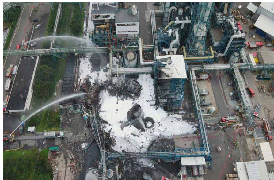
Foto 3.1 Bovenaanzicht van de ontplofte tank op CHEMPARK in Leverkusen-Bürrig (bron: CURRENTA)
